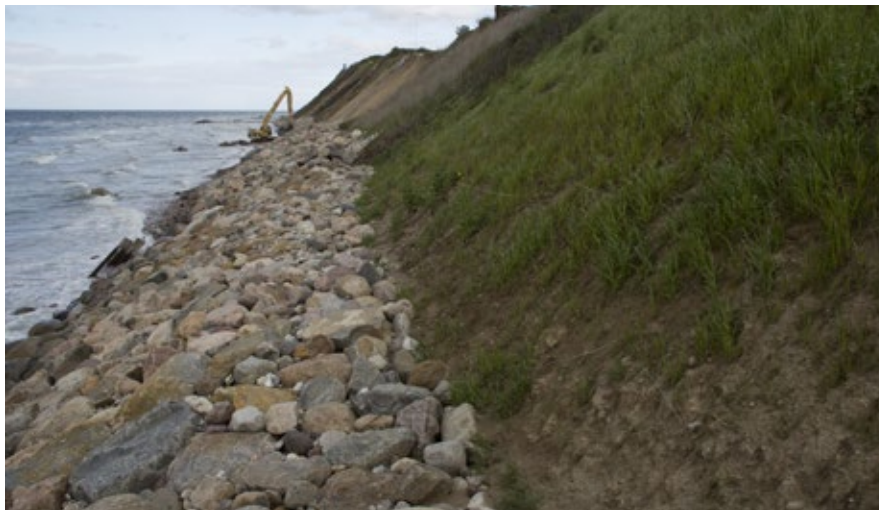
Figur nr. 14 viser stenkastning på nabostrækning etableret til ca. kote 3,5 m over dvr90. Foto taget den 7. maj 2015 af Kyst-havneviden
