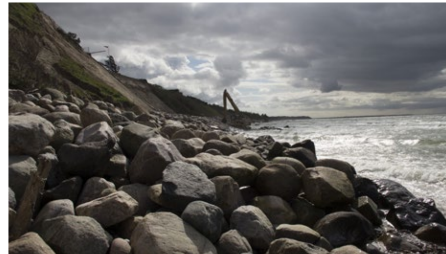
Figur nr. 15 viser stenkastning på nabostrækning etableret til ca. kote 3,5 m over dvr90. Foto taget den 7. maj 2015 af Kyst-havneviden
